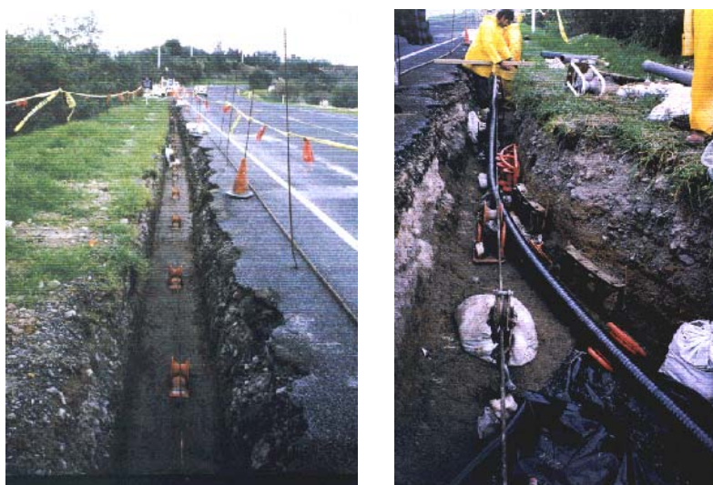
รูปที่ 4.10 การติดตั้งสายเคเบิลใต้ดินใต้ดินแบบฝังดินโดยตรง
