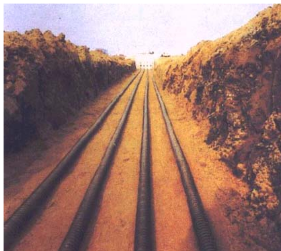
รูปที่ 4.5 การขุดดิน และการวางท่อ
