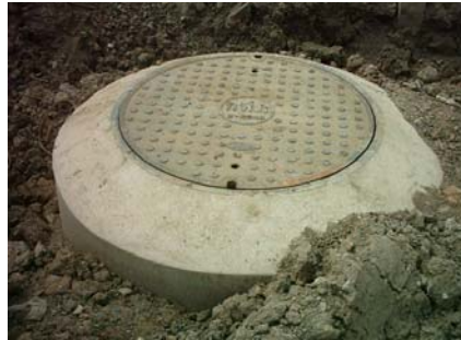
รูปที่ 2.18 Manhole Cover
