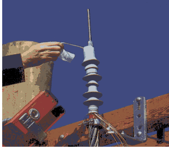
รูปที่ 2.41 แสดงตัวอย่างหัวสายเคเบิลใต้ดินแบบ Cold Shrink Type
