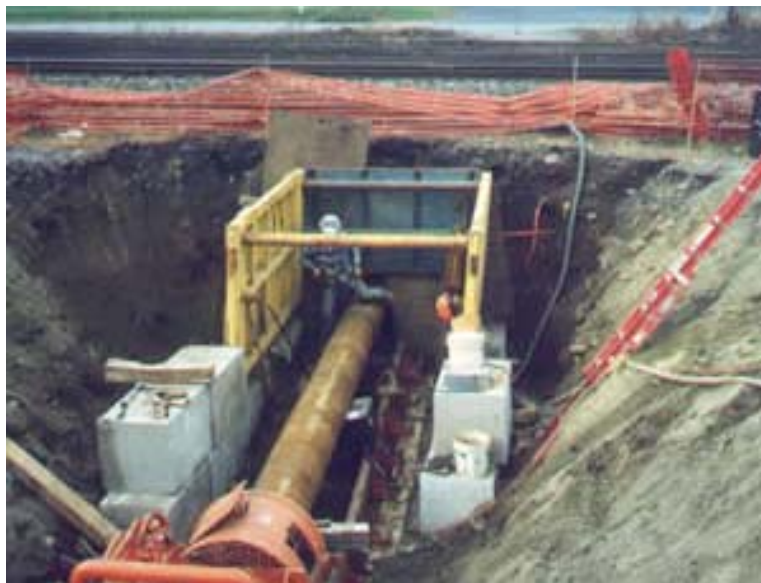
รูปที่ 2.4 Pipe Jacking
