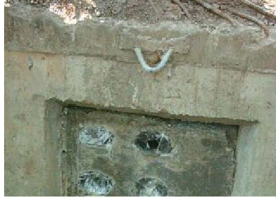
รูปที่ 2.6 Pulling Iron และการติดตั้ง Pulling Iron
