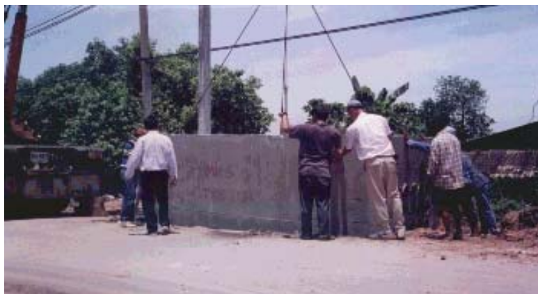
รูปที่ 4. 19 การวางบ่อ Manhole
