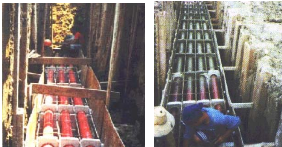
รูปที่ 4.1 การก่อสร้าง Duct Bank
