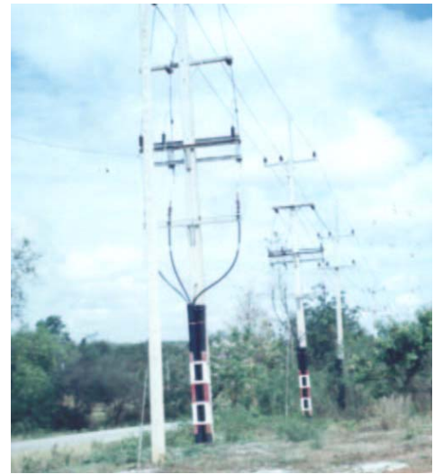
รูปที่ 2.22 รูปแสดงการติดตั้งที่มีระบบจำหน่ายหลายวงจร และมี Outgoing สองวงจร
