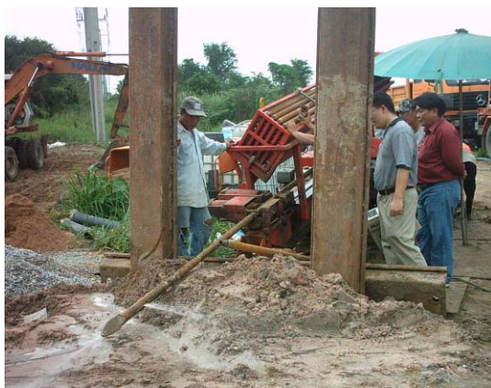
รูปที่ 4.11 ขั้นตอน Guide Drills หรือ Pilot Bore
