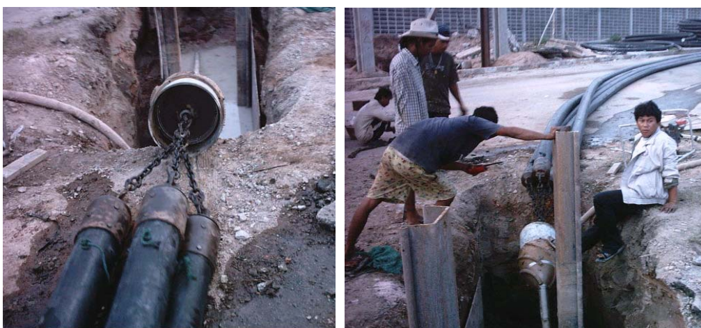
รูปที่ 4.13 การทำ Pulling Pipe
