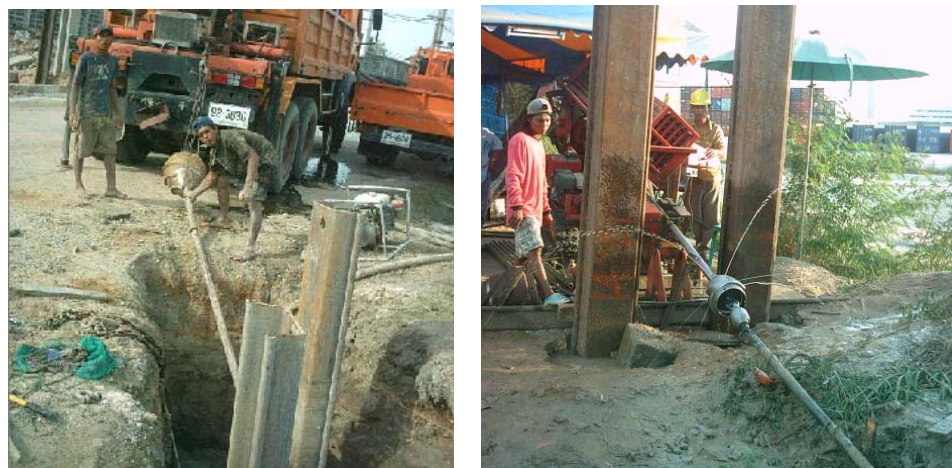
รูปที่ 4.12 การทำ Back Reamer
