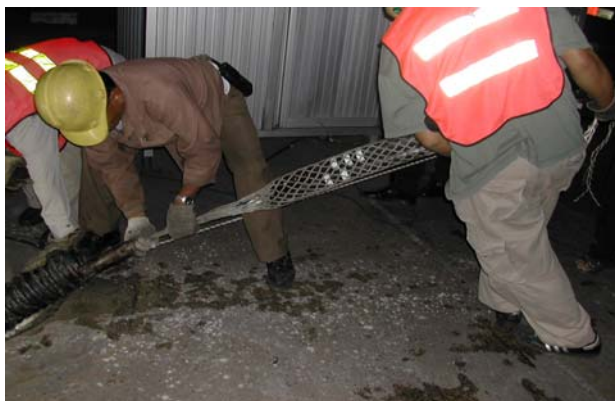
รูปที่ 6.9 รูปแสดงการเข้าหัวพูลลิงกริป (Pulling Grip) ที่ปลายสายเคเบิลใต้ดิน
