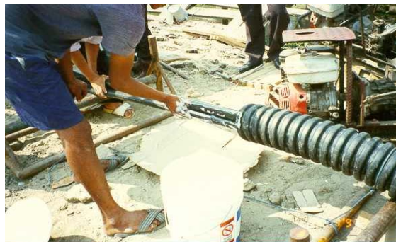
รูปที่ 3.29 แสดงการใช้สารหล่อลื่นช่วยในการดึงลากสายเคเบิลใต้ดิน
