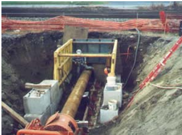
รูปที่ 3.5 Pipe Jacking
