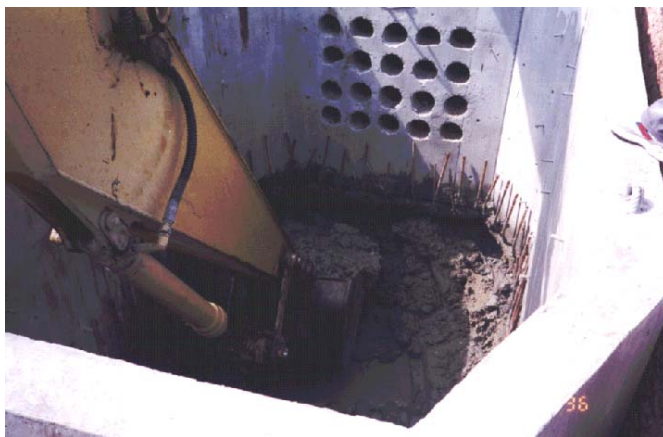
รูปที่ 4. 20 การขุดดินออกเพื่อจอมบ่อ
