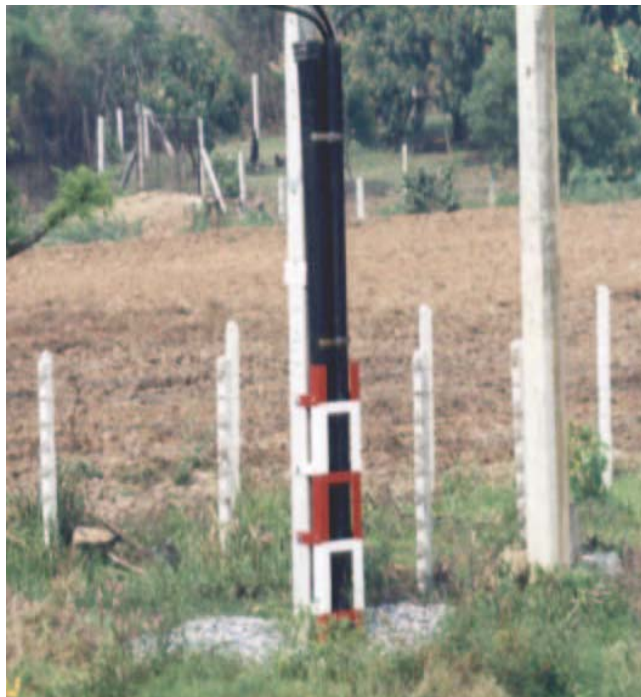
รูปที่ 2.21 กรณีไม่มีหญ้าขึ้นปกคลุมหนาแน่น และบริเวณรอบๆ เป็นพื้นที่โล่งว่าง ไม่จำเป็น ต้องใช้ท่อ RSC ก็ได้
