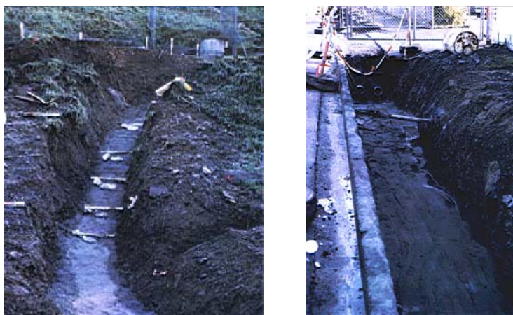
รูปที่ 4.9 การอัดทรายที่ก้นร่อง
